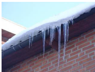
Bild 2. Istappsbildning pga av värmen från vindsutrymmet
