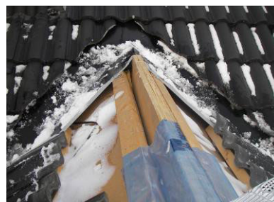
Bild 19. Yrsnö på vindstrymmet är en signal om brist som bör påtalas men som inte hindrar fortsatt isoleringsarbete.
